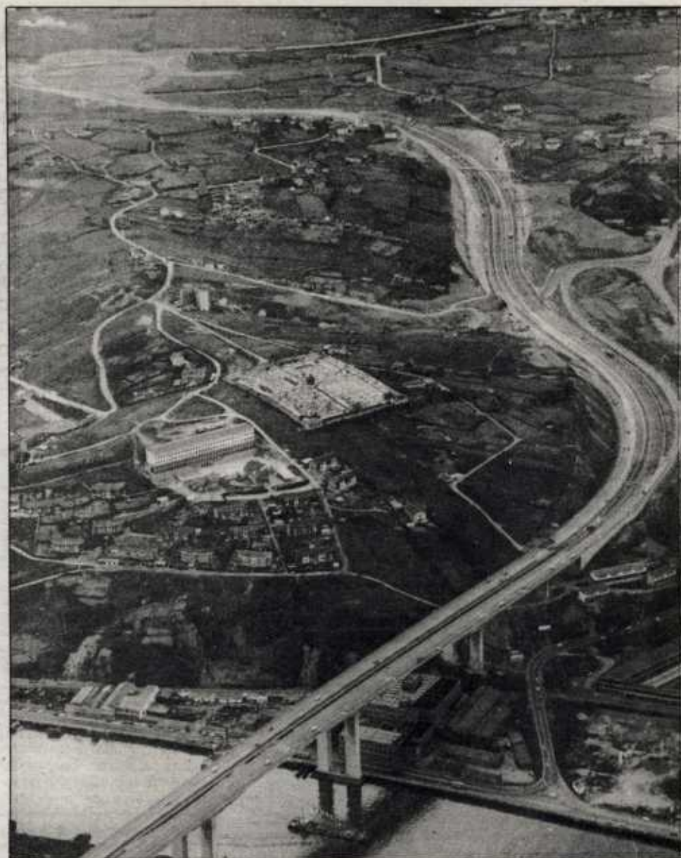
Vista aérea de los nuevos accesos. Arriba, a la izquierda, la «rotonda».
