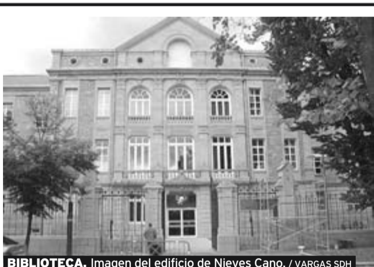
BIBLIOTECA. Imagen del edificio de Nieves Cano. / VARGAS SDH
