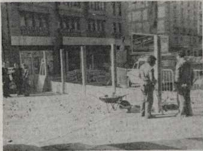
La Caja de Ahorros Municipal ha iniciado las obras para la construcción del paso inferior de acceso a su aparcamiento subterráneo
