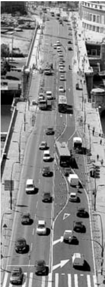
Vista aérea del puente. / B. AGUDO
