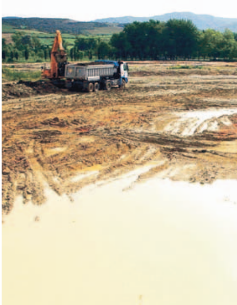
OLÁRIZU. Trabajos de limpieza del suelo. / JESÚS ANDRADE
