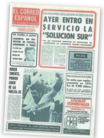
Imágenes de las obras y portada del día de la inauguración.
