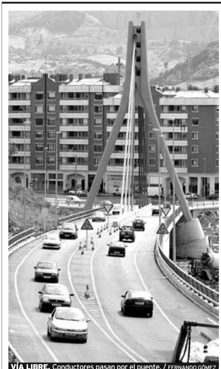
VIA LIBRE. Conductores pasan por el puente. / FERNANDO GÓMEZ
