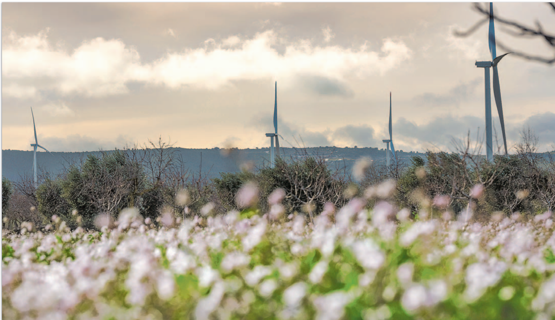
Parque eólico de Forestalia en las Cinco Villas (Zaragoza). / Foto: Pedro Etura
