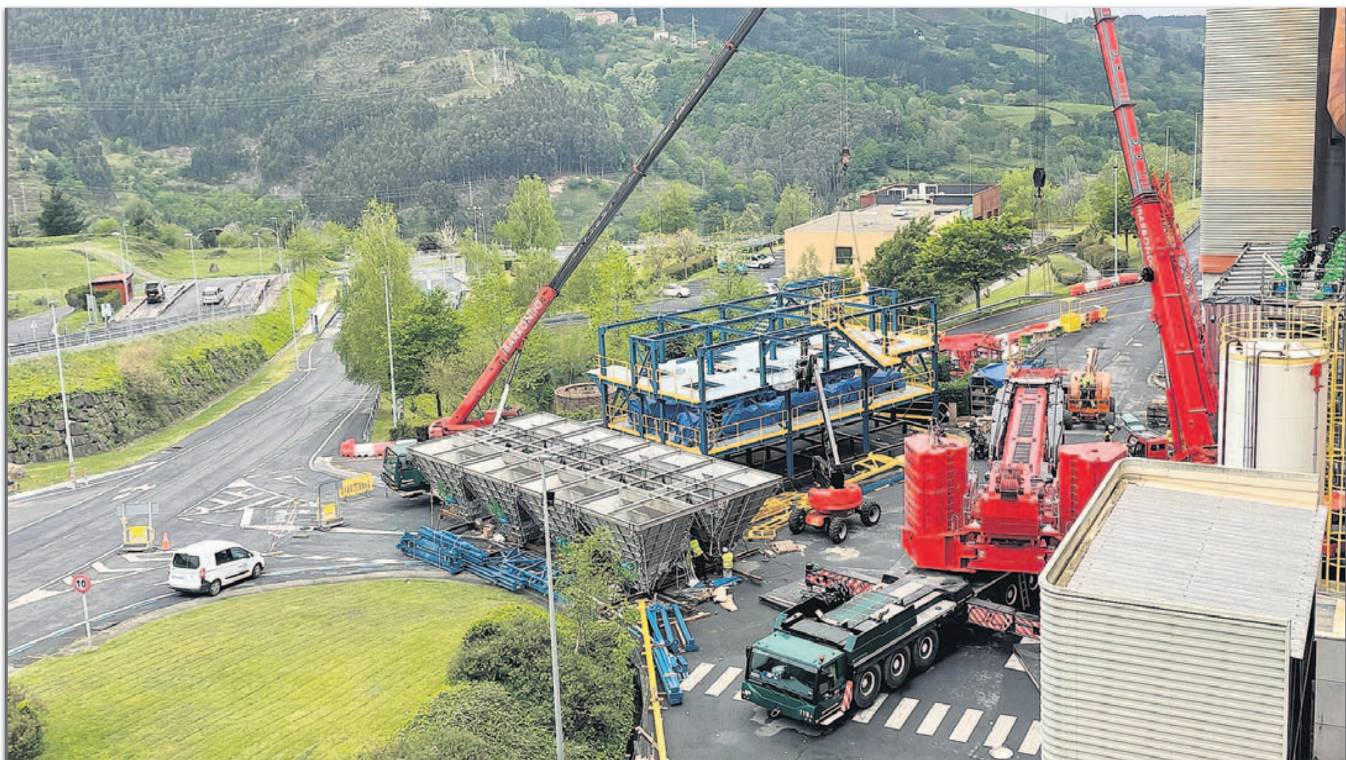
El cambio del filtro de mangas ha sido la mayor intervención en la planta y ha supuesto una operación muy compleja.
