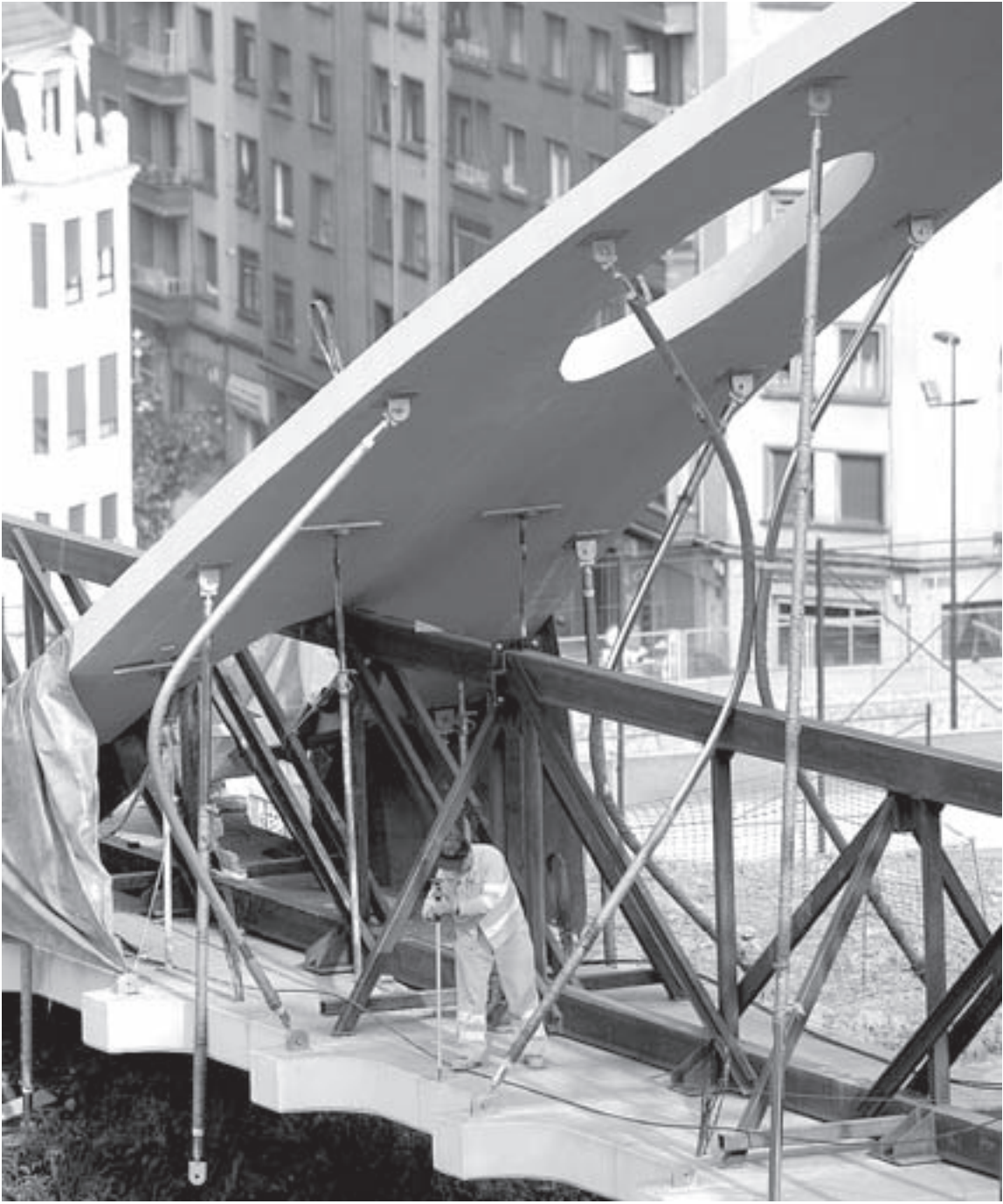
UN OPERARIO inspeccionaba ayer el arco agrietado, donde algunos tirantes están doblados. / F. GÓMEZ
