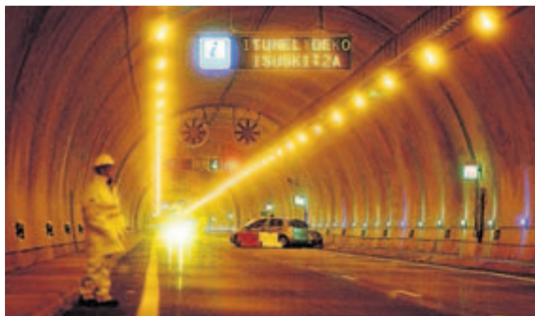
VISTA interior del túnel de Isuskizta. / IOSU ONANDIA
