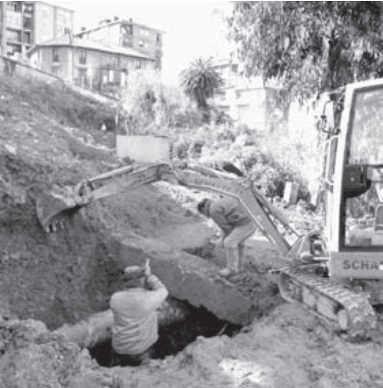
OPERARIOS trabajan para sustituir la tubería. / JORDI ALEMANY
