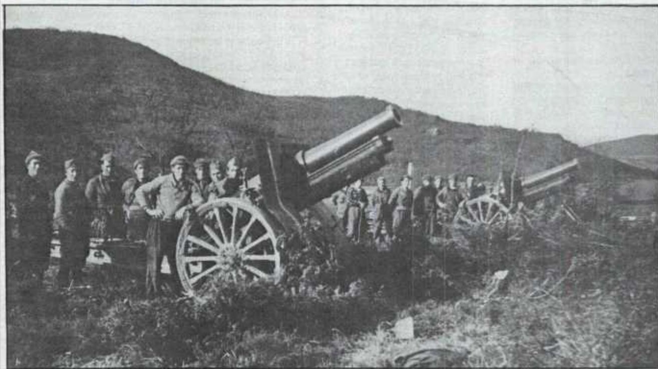
Durante casi dos semanas, tras la caída de Bilbao, el avance de las tropas del general Dávila tuvo, a menudo, las características de un paseo militar dada la desmoralización de sus oponentes.
