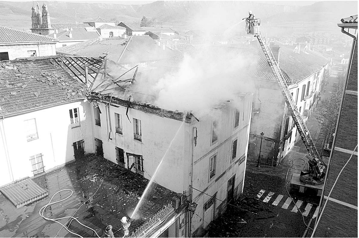
EN EL TEJADO. Los bomberos sofocan las llamas que arrasaron la cubierta. / L. CALABOR / MITXEL ATRIO
