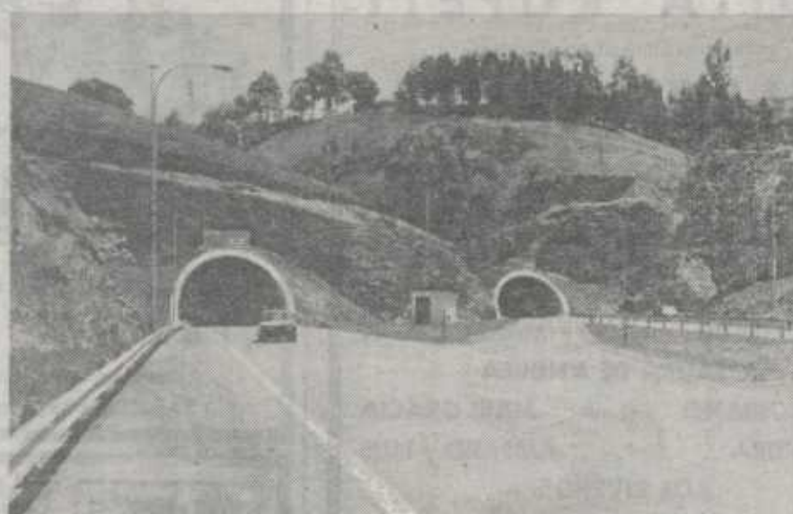
Una vista de los túneles de Meagas, de 450 metros de longitud, situados en el tramo de Zumaya a Zarauz. La fotografía es el mejor ejemplo de las dificultades orográficas que han tenido que salvarse para la ejecución de la autopista.
