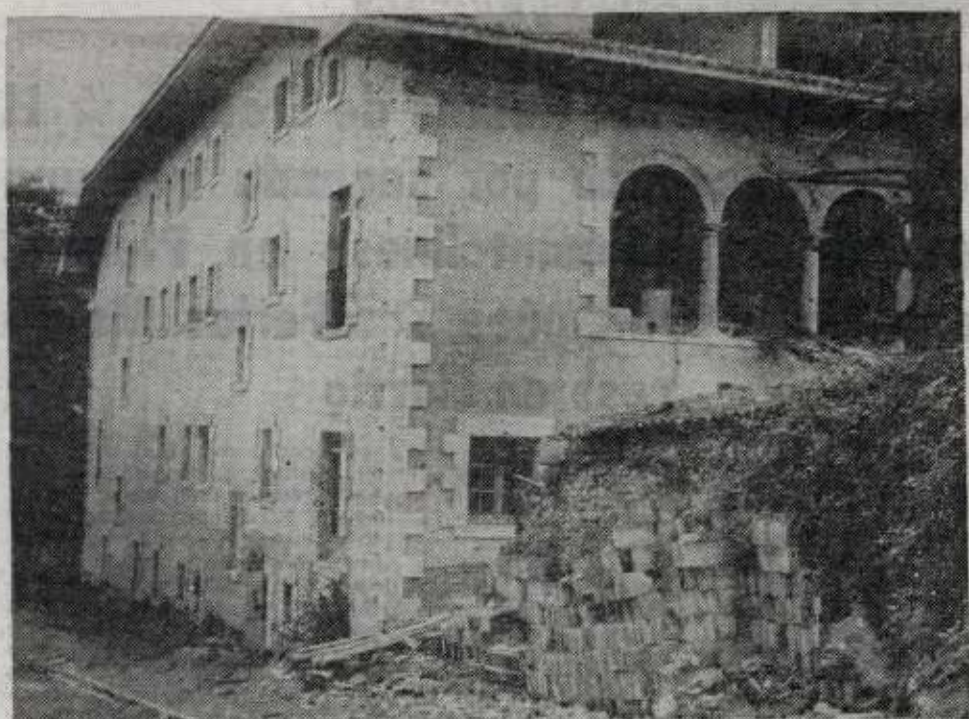
Una vista del abandono del Hostal de Elorrio donde, entre edificios y obras se habrán invertido cien millones.
