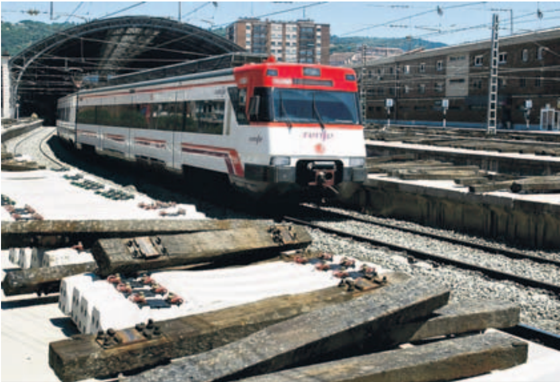
ARREGLOS. Las traviesas de madera serán sustituidas por otras de hormigón. / MITXEL ATRIO
