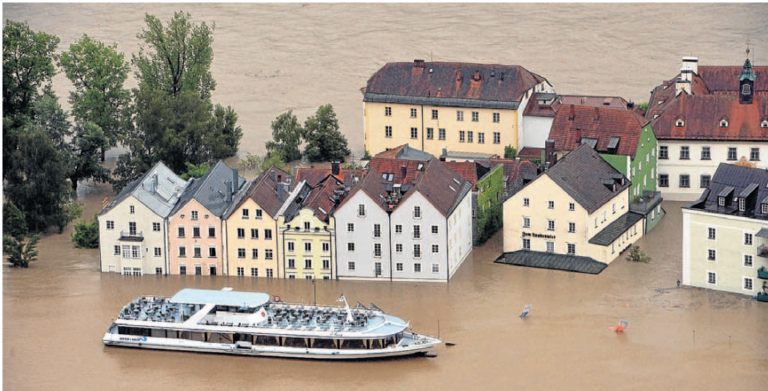
Un barco, junto a las casas anegadas por el agua en la localidad alemana de Passau. :: PETER KNEFFEL/EFE
