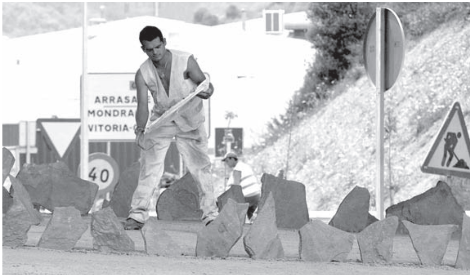
ÚLTIMOS TRABAJOS. Dos operarios, ayer por la tarde, en las obras de la autopista. / JULIO CALLEJA
