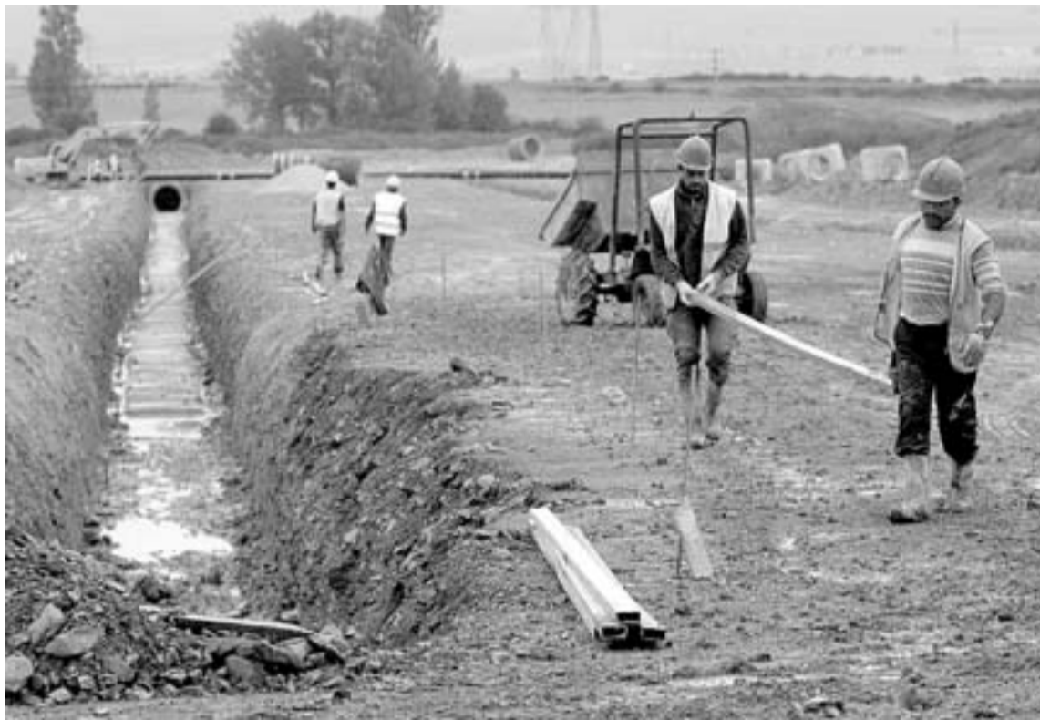
TRABAJOS de urbanización en la futura zona residencial de Zabalzana. / JOSÉ MARI LÓPEZ
